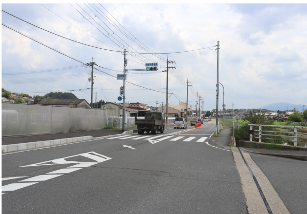
改良された協和橋東詰交差点
